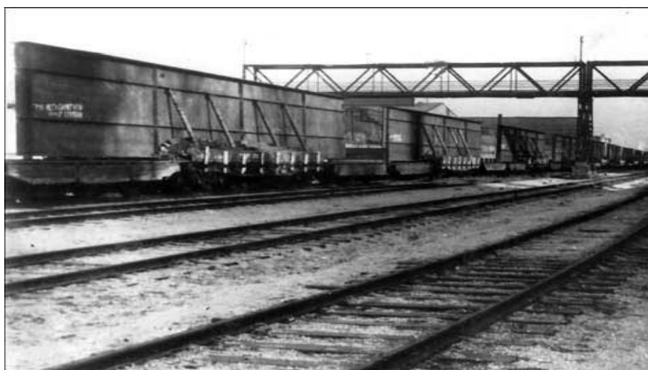
Рисунок 11 Эшелон с главными балками на заводских путях
