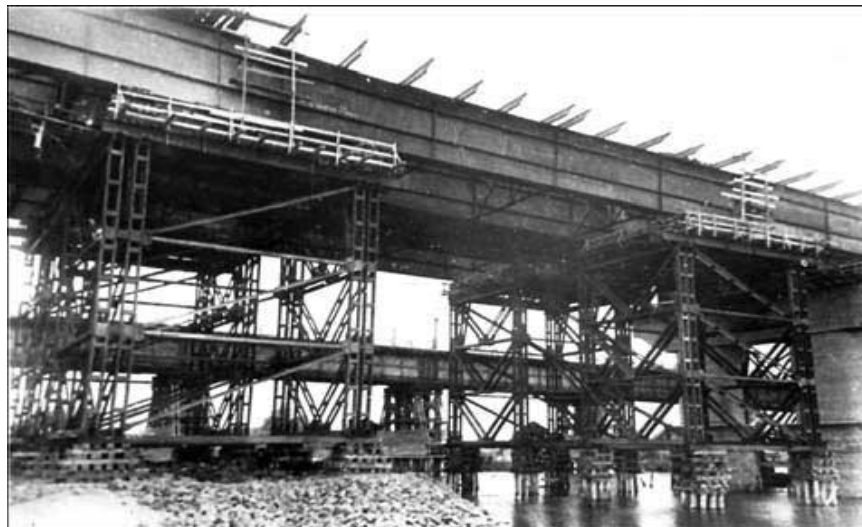
Рисунок 14 Общий вид сварного монтажного стыка в пролете
