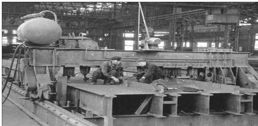
Рисунок 2 Общий вид траверсы кондуктора для сборки и сварки крупногабаритных монтажных элементов в цеху ЗМК
