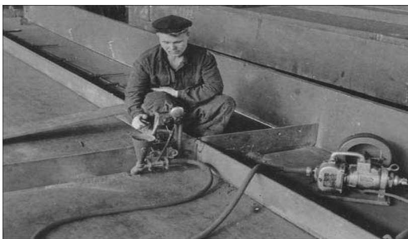
Рисунок 6 Приварка ребра жесткости полуавтоматом ПШ-5
